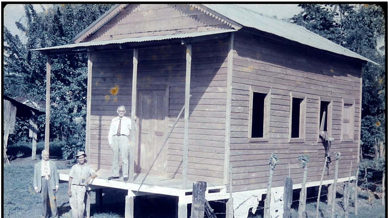
Don Alfredo Hockings y don Juan Ruddock supervisando la construcción de una Sala Evangélica.
